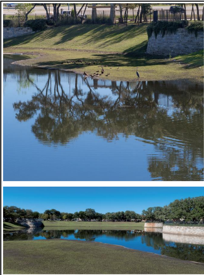
Figura 13 – Esempi di bacini di detenzione per lo stoccaggio delle acque di pioggia a seguito di eventi meteorici di forte intensità.
